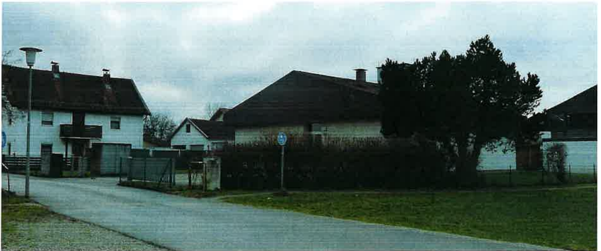
Bild3: im Westen angrenzendes Gebäude (Verwaltungsgebäude) (Wandhöhe unter 3,50m)
