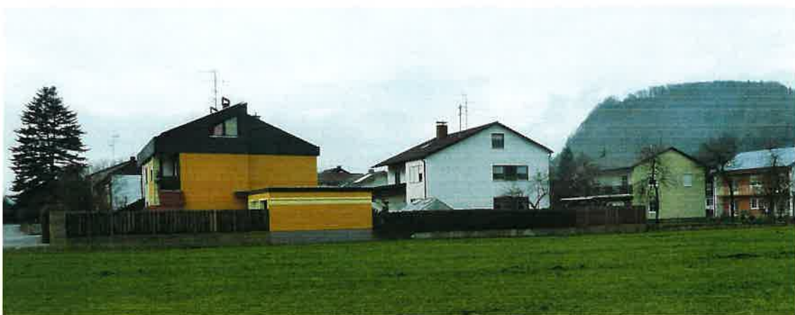
Bild 4: angrenzende Häuserzeile im Nordwesten mit einer Dachneigung unter 25°
